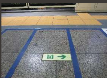
■施工例 東京メトロ
