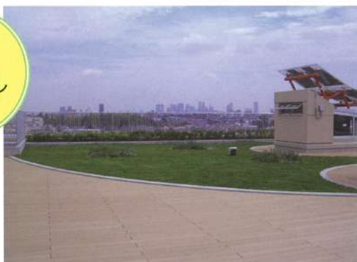
エコスクール施工例（薄層緑化+ウッドデッキ）
